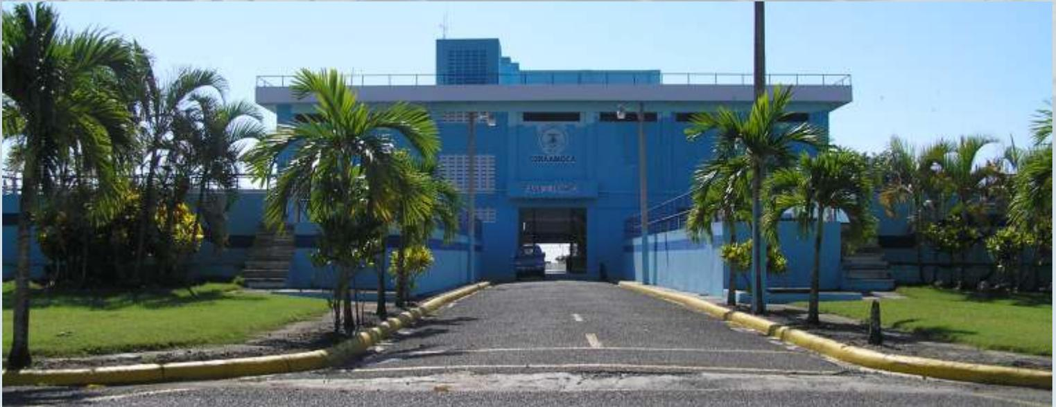
La planta potabilizadora La Dura ha sido diseñada para tratar un caudal de hasta 1.5 m<sup>3</sup>/seg. donde se llevan a cabo los procesos de mezcla rápida, coagulación, floculación, sedimentación, filtración y cloración, a fin de eliminar turbidez, color y cargas bacteriológicas.
